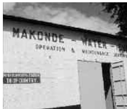
Estación Elevadora de Presión Hidrica
